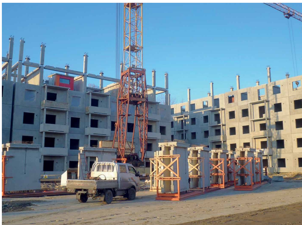
Система РКД: строящееся здание
